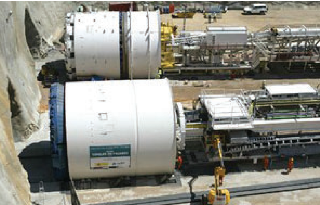
Figura 3. Tuneladoras construyendo un túnel de doble tubo.
