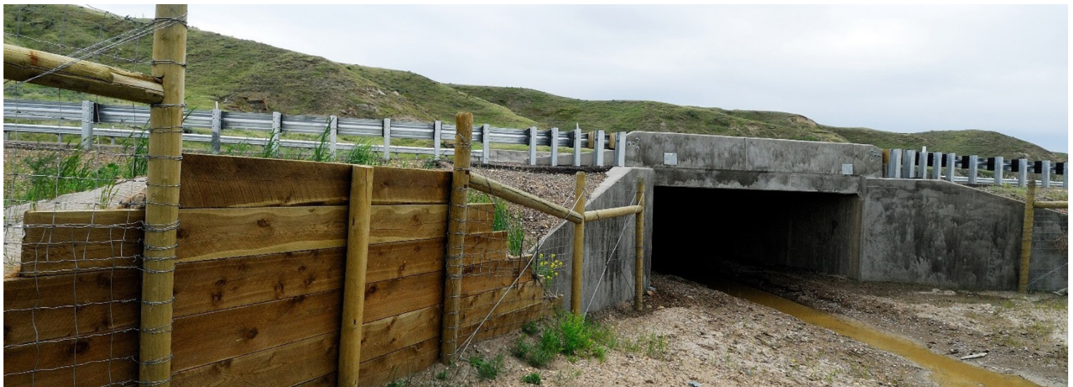
Figura 8. Combinación de paso inferior/drenaje de agua y rampa de escape de fauna silvestre
