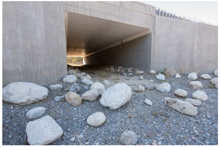
Hình 6. Lối Chui Qua Đường Điển Hình cho Động Vật Hoang Dã
