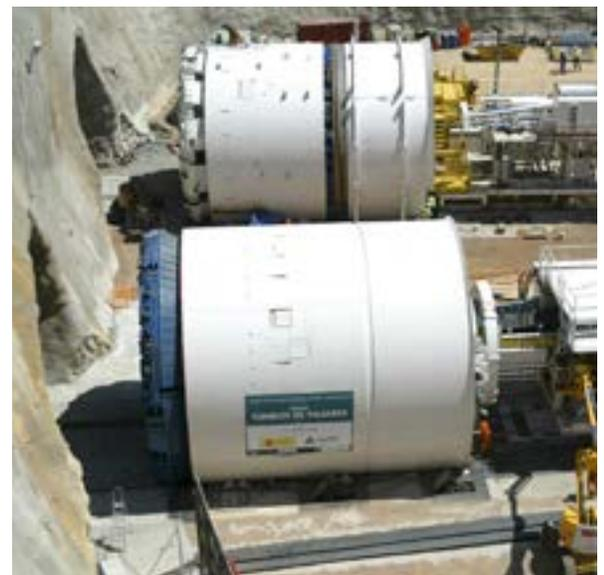
Figura 2. Foto de máquinas tuneladoras que construyen un túnel de doble perforación.
