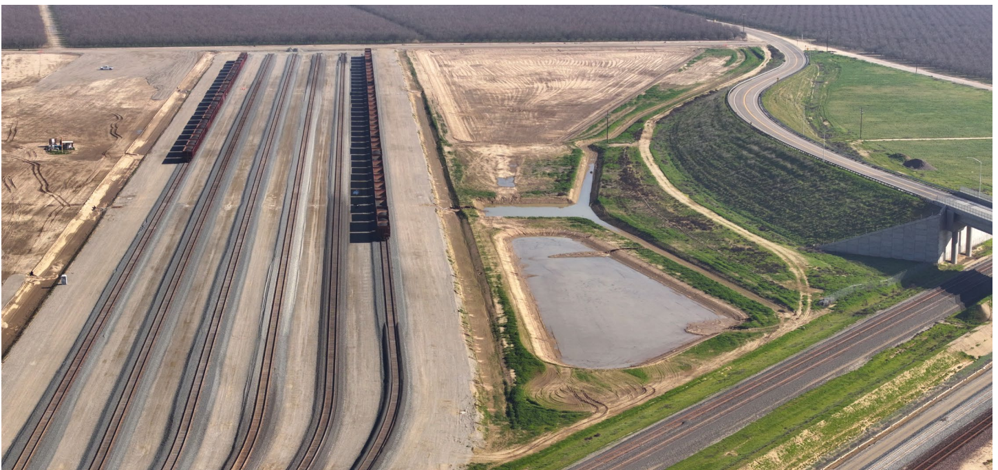
Vista aérea de la obra de la Cabecera Ferroviaria Sur
