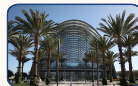
Estación de Anaheim (ARTIC – Anaheim Regional Transportation Intermodal Center)
